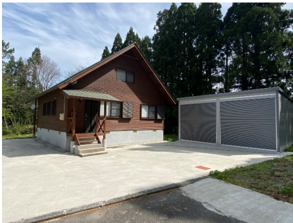
正面（駐車場・車庫）
